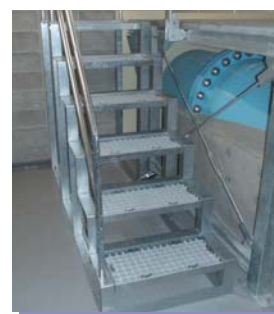
施設内階段製作
