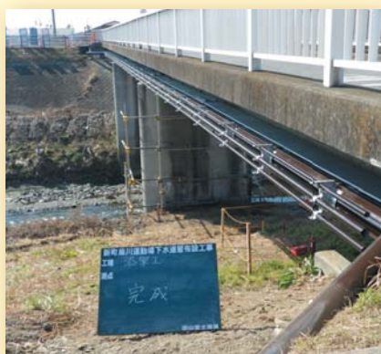
群馬県 新栄橋 100A (下水ポリ) / \phi 200 L=54.3m
