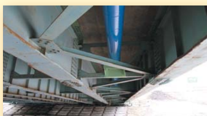
北海道石狩管内 三角新川橋 200A / 300A L=50.2m
