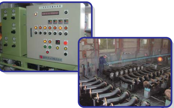
9. ポリウレタン被覆 埋設管等の保護のため、専用の機械で塗布し 優れた防食性能を期待できます。
