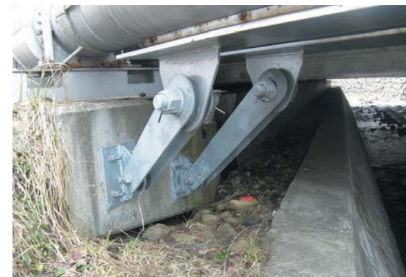
・ピン等で橋台からの落下を防ぎます。 ※ピンの製作はしていません。
