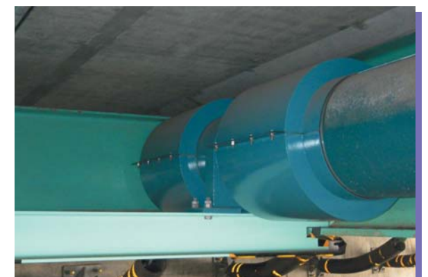
支持金具を増やし、リングサポートで固定し、添架管の橋からの落下を防ぎます。
