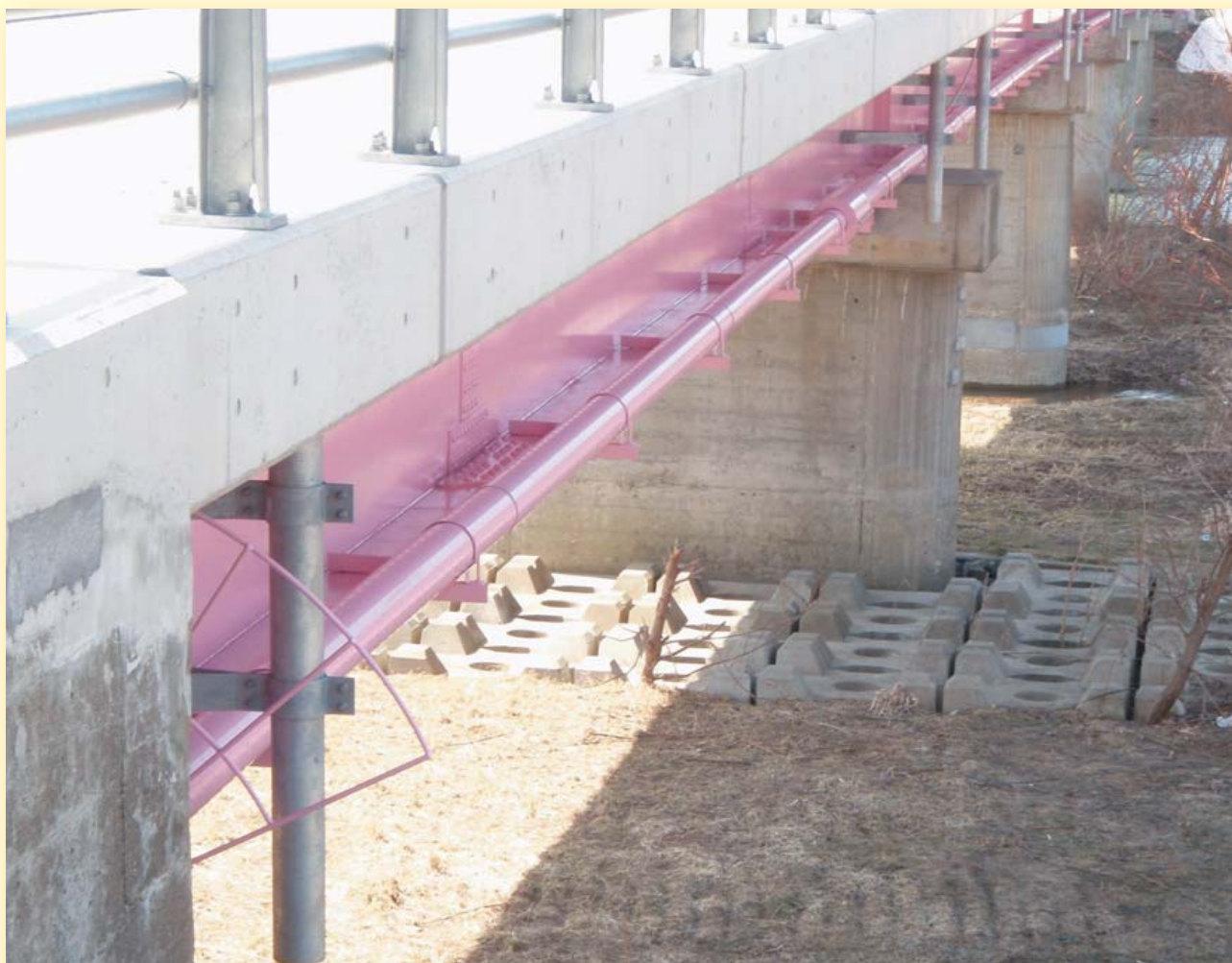
北海道檜山管内 小森大橋 80A / \phi 200 L=171.39m
