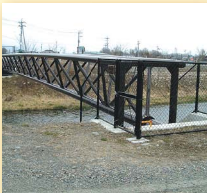
長野県 等々力橋水管橋 200A / 300A L=36.1m
