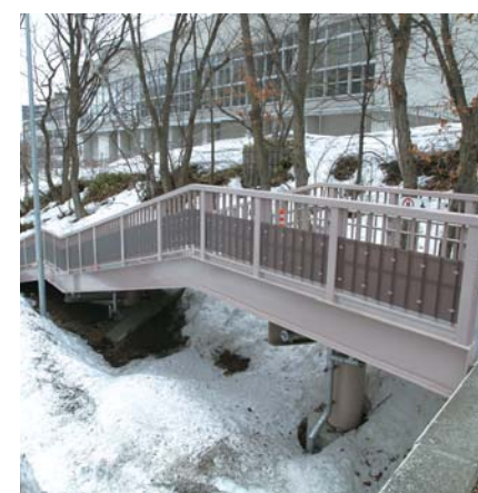
歩道橋製作・設置
