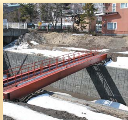
北海道胆振管内 西山川横断橋 100A / 300A L=16.6m (橋長) 50A / 200A
