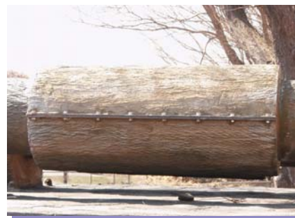
FRP 加工で製作された擬木を伸縮力バーとしています。
