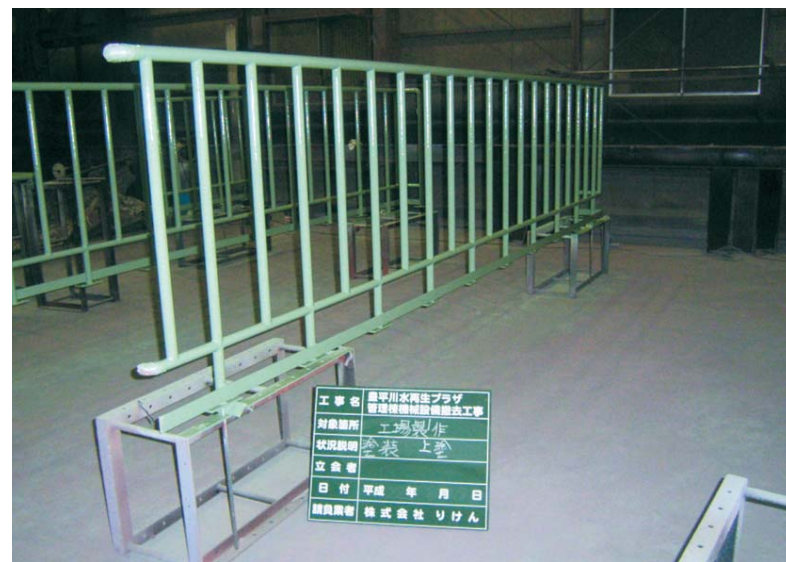
施設内手摺製作・設置
