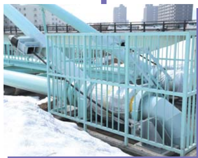
伸縮可撓管を取替え性能をアップさせ大地震からの水管橋の破壊を防ぎます。
