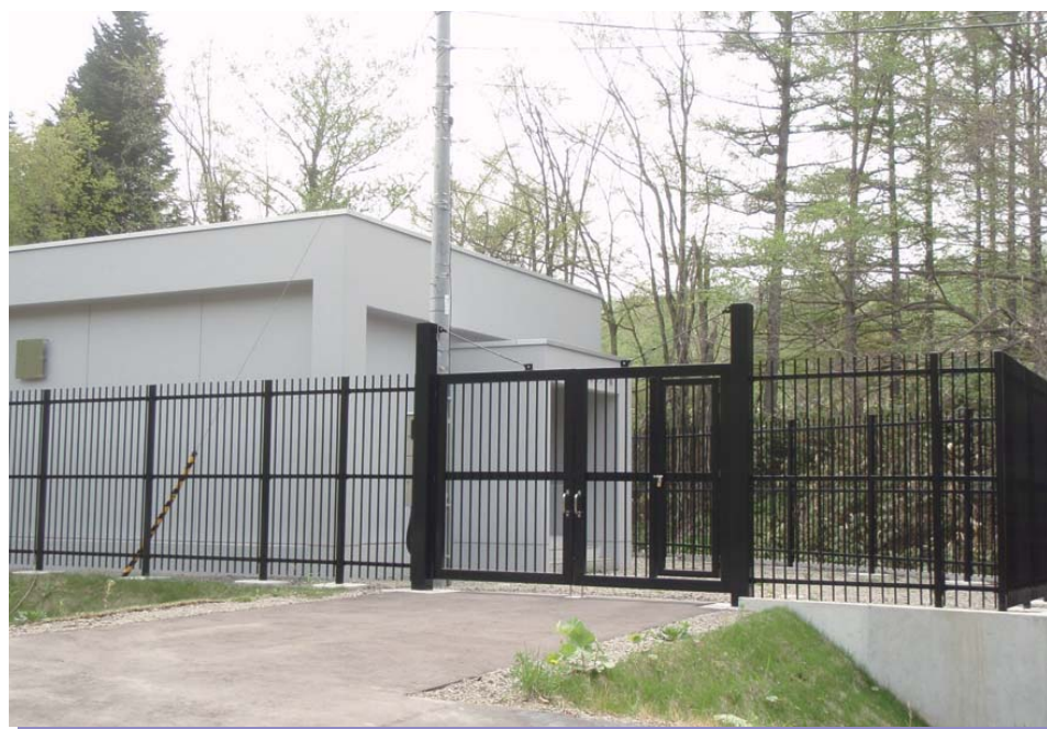
門扉・フェンス製作・設置
