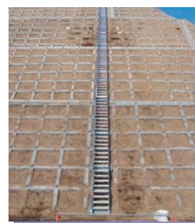
鋼製階段製作・設置
