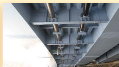
北海道石狩管内 南栄橋 上水道 200A / φ300 L=49.7m 下水道 200A / 300A L=67.247m
