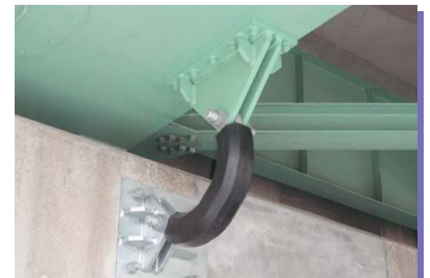
・ゴムチェーン等で橋脚からの落下を防ぎます。 ※ゴムチェーンの製作はしていません。
