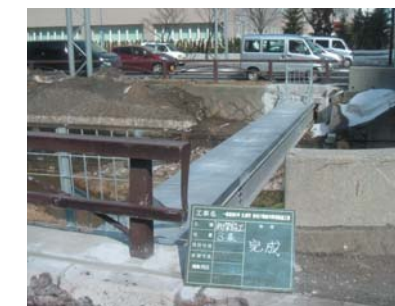
電線共同溝用桁製作・設置
