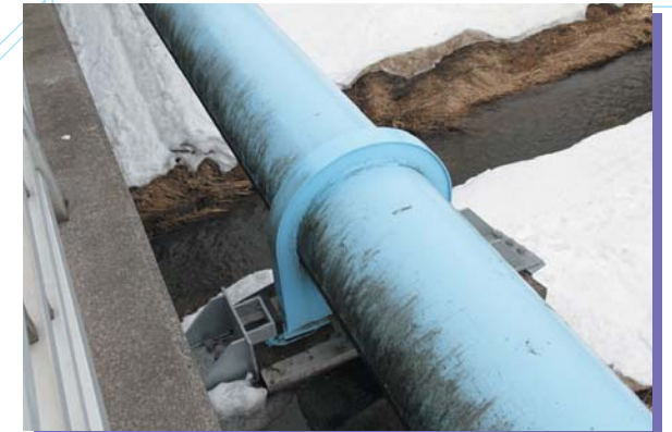
・橋軸直角方向に金具を取付け、橋脚からの落下を防ぎます
