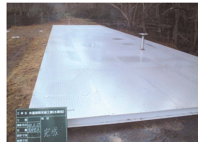
水源地ふた製作・設置
