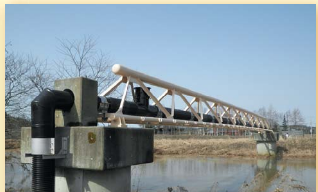
北海道厚岸郡厚岸町 第3尾幌水管橋 200A / 350A L=38.1m
