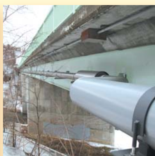
北海道石狩管内 柏橋 150A / φ250 L=103.6m
