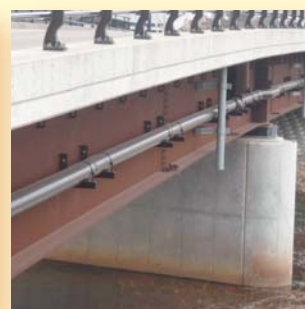
北海道渡島管内 久根別7号橋 75A(下水ポリ) / 200A L=70.0m
