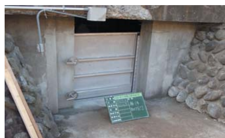
ろ過池扉製作・設置
