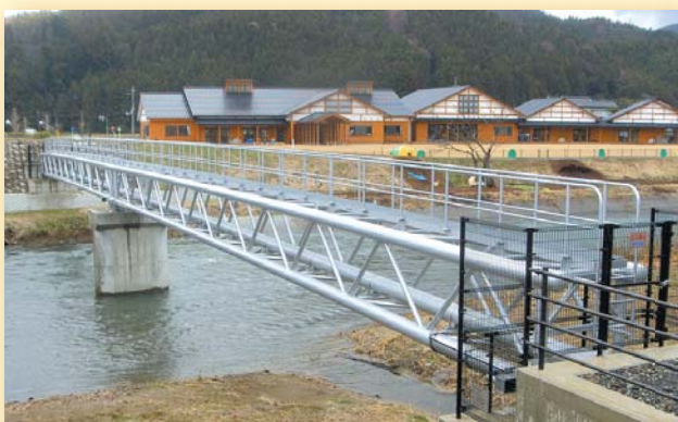
山形県 荒瀬川水管橋 250A / \phi 325 L=61.7m
