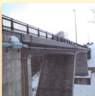
北海道網走管内 明向大橋 100A(水道ポリ) / \phi 200 L=130.83m
