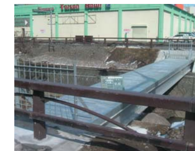
電線共同溝用桁製作・設置
