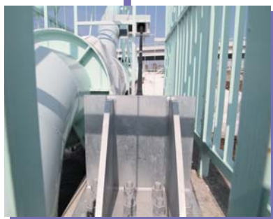
橋軸直角方向へ金具を取付け橋台からの落下を防ぎます。
