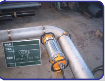
5.X 線検査 溶接完了後、溶接部分にX線検査を 行い溶接管理を行っています。
