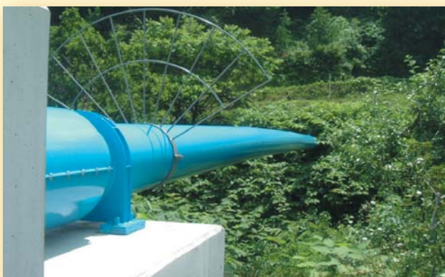
北海道後志管内 赤岩水管橋 150A / 500A L=37.0m
