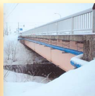
北海道宗谷管内 豊富橋 150A(水道ポリ) / 250A L=51.1m
