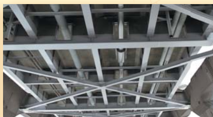
北海道石狩管内 ボンノッポ口橋 200A / φ300 L=115.65m
