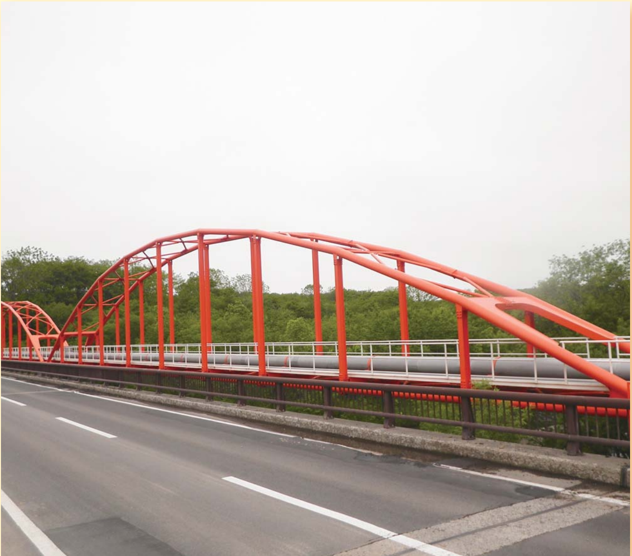
北海道根室管内 中標津水管橋 500A / 550A L=101.6m
