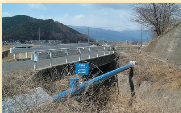
長野県 第一田川橋水管橋 250A / 350A L=17.0m
