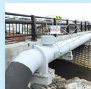
北海道石狩管内 興産社橋 500A / 600A L=21.938m
