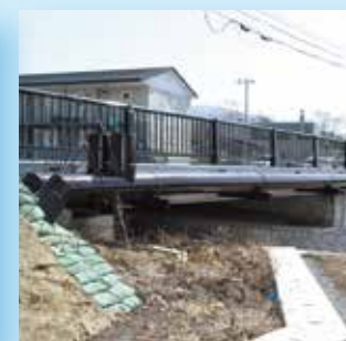
北海道胆振管内 赤川2号橋 200A / 350A 2条 L=22.1m
