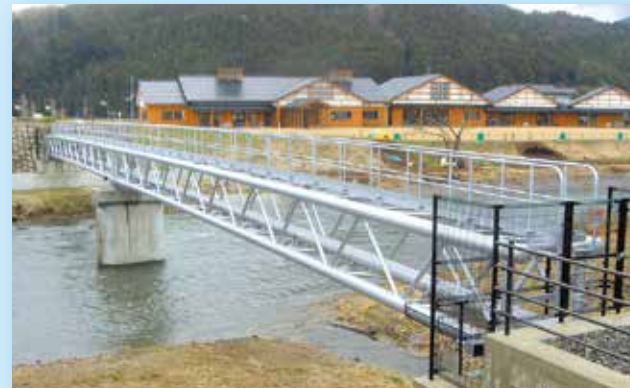
山形県 荒瀬川水管橋 250A / φ 325 L=61.7m
