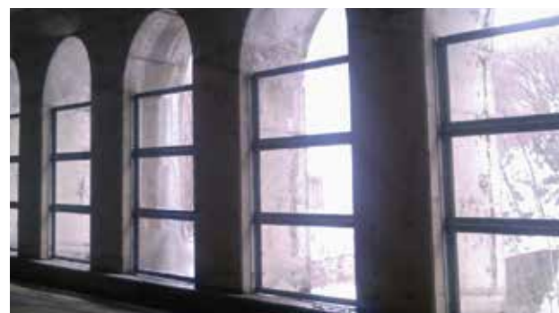
ポリカーボネート吹き込み防止板製作
