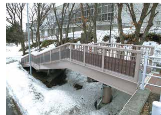
歩道橋製作・設置
