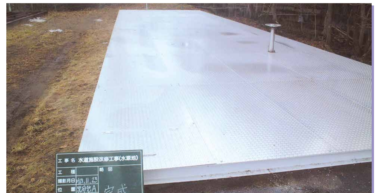
水源地ふた製作・設置
