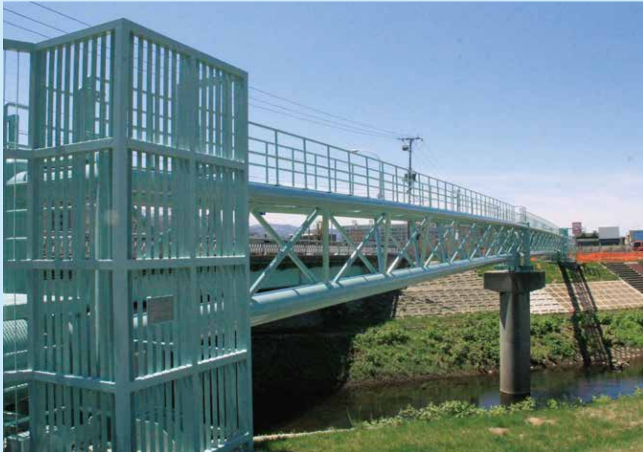
北海道石狩管内 中の川第1水管橋 400A / 500A L=81.2m
