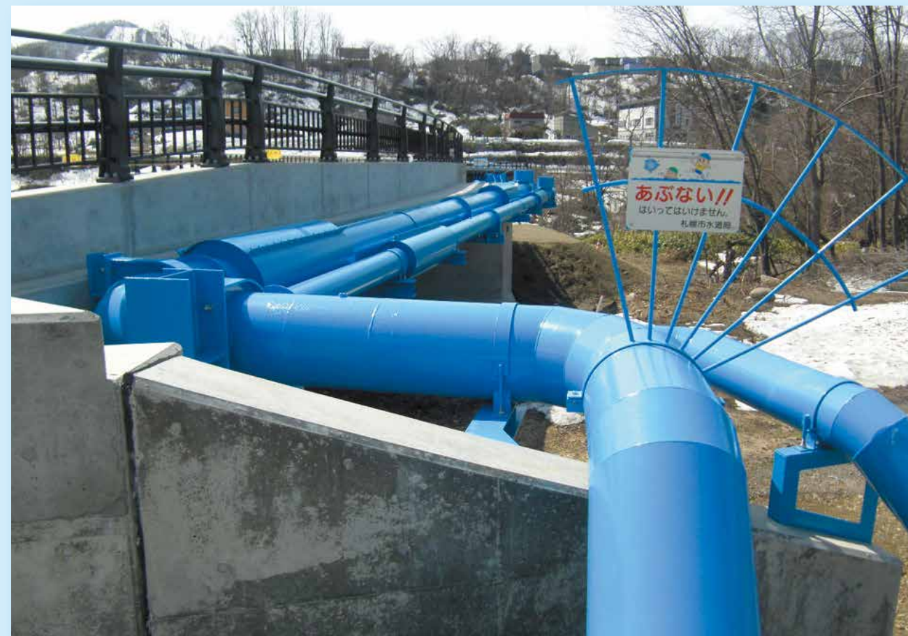
北海道石狩管内 導水路防護橋 外側 100A / 250A L=35.978m 内側 350A / 450A L=36.976m
