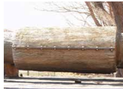
FRP 加工で製作された擬木を伸縮カバーとしています。
