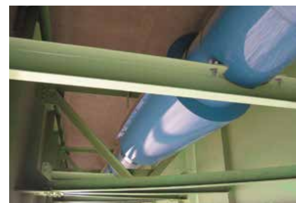
支持金具を増やし添架管の橋からの落下を防ぎます。
