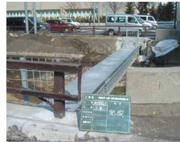
電線共同溝用桁製作・設置
