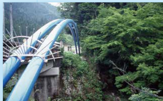
愛知県 滝の口アーチ橋 80A / 250A L=29.0m
