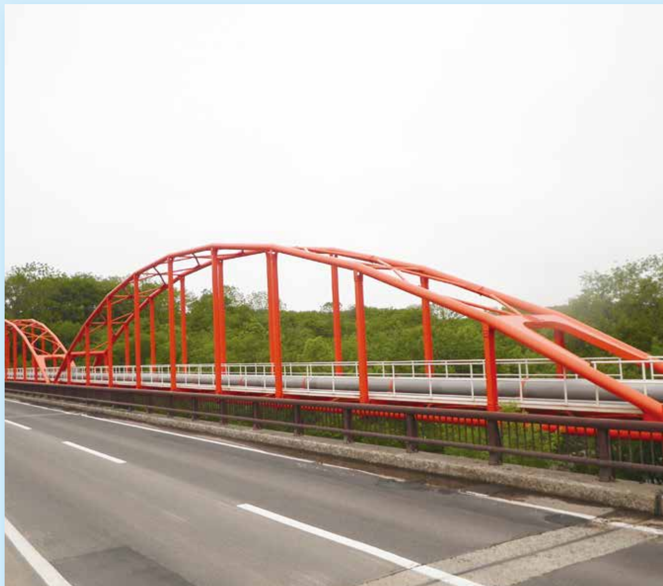
北海道根室管内 中標津水管橋 500A / 550A L=101.6m
