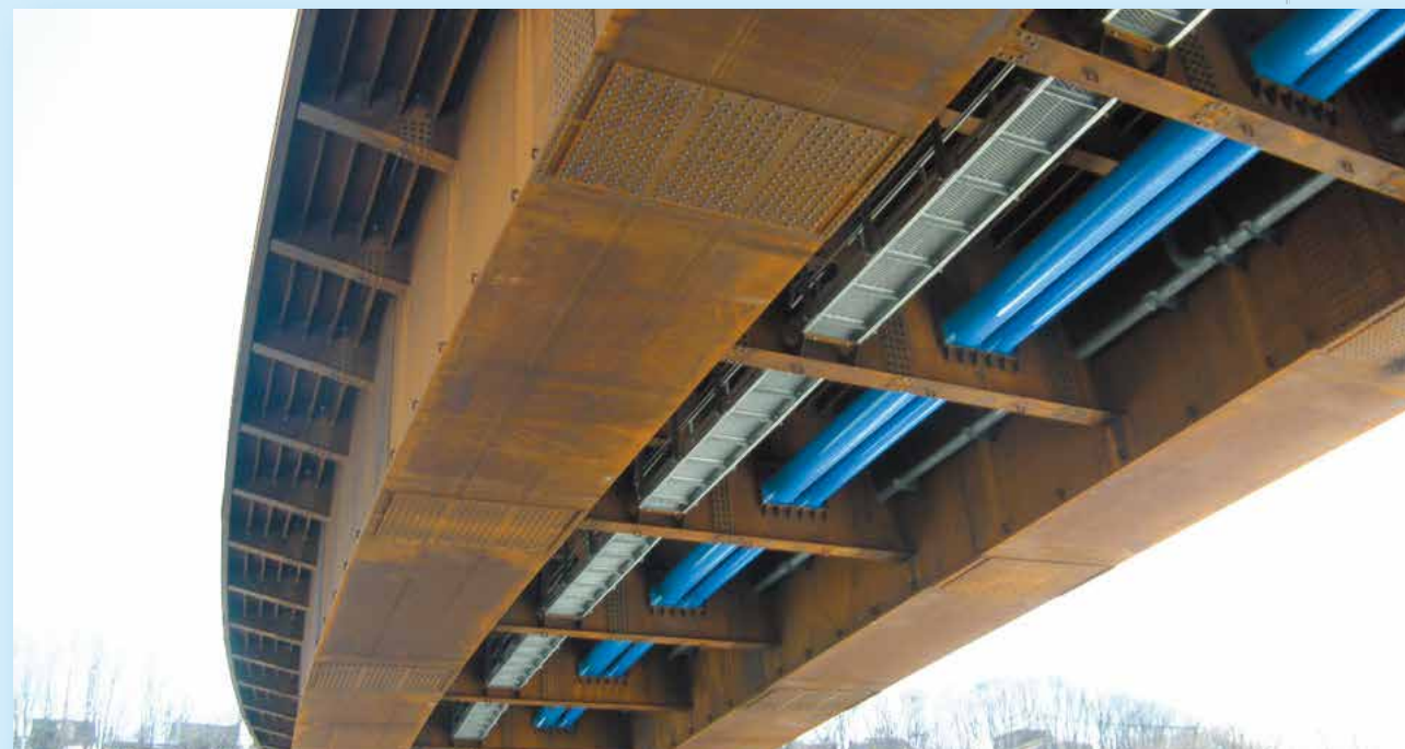
北海道石狩管内 新御料橋 右側 100A / 250A L=93.288m 左側 350A / 450A L=93.434m
