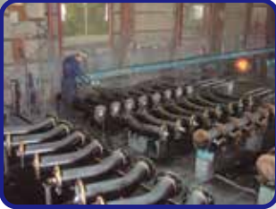
9. ポリウレタン被覆 埋設管等の保護のため、専用の機械で塗布し 優れた防食性能を期待できます。
