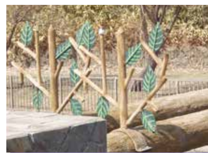
FRP 加工で製作された枝・葉を立入禁止柵としています。
