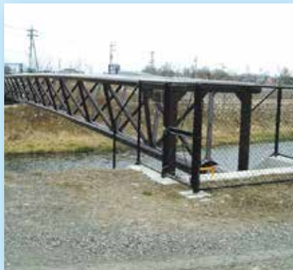
長野県 等々力橋水管橋 200A / 300A L=36.1m
