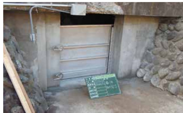
ろ過池扉製作・設置
