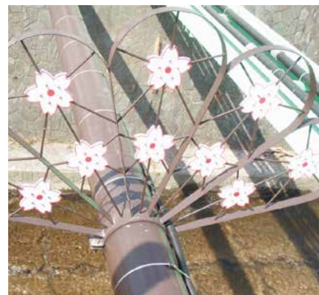
城下町の景観を考え、桜模様を鉄板で製作して立入禁止柵に取付けています。
