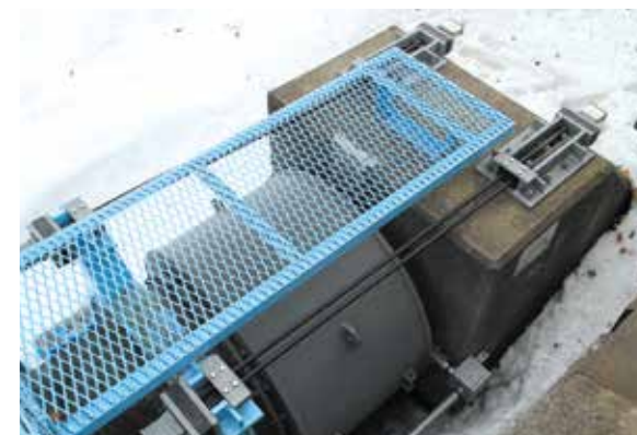
・ケーブル等で橋台からの落下を防ぎます。 ・地震時の漏水防止対策として伸縮継手に専用のカバーを取付けます。 ※専用カバーの製作はしていません。
