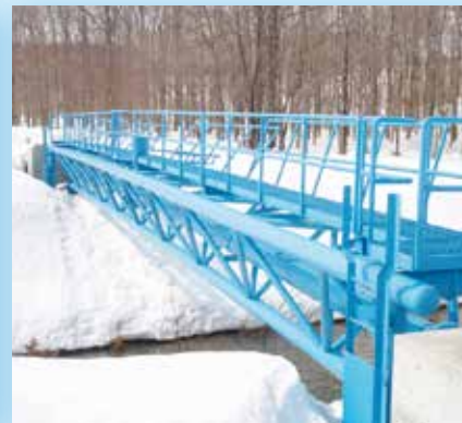
北海道宗谷管内 小頓別水管橋 200A / φ 300 L=40.9m
