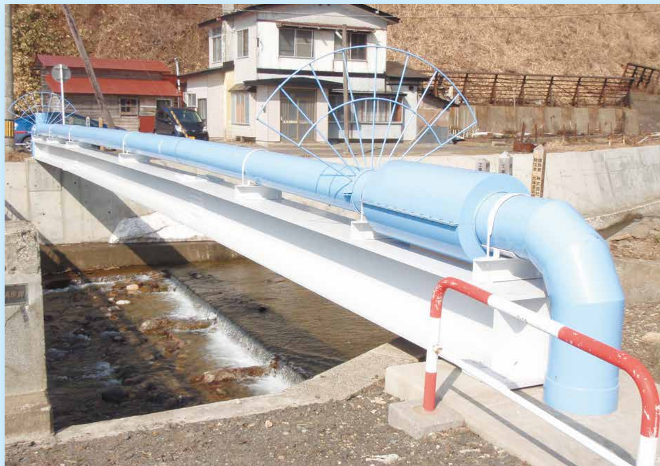
北海道渡島管内 板橋水管橋 300A / φ375 L=31.9m
