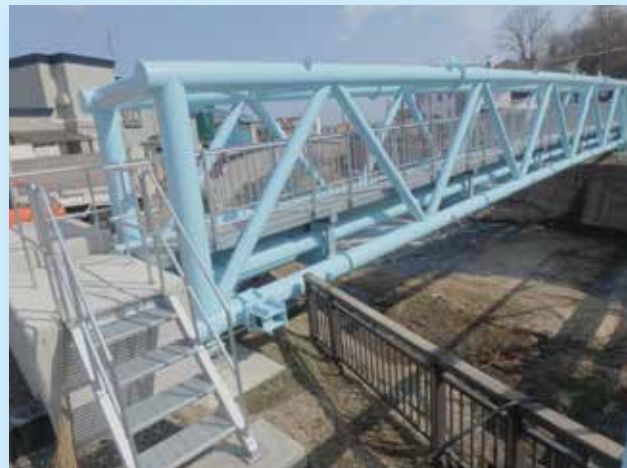
北海道後志管内 勝納水管橋 600A/700A 200A/300A L=35.55m
