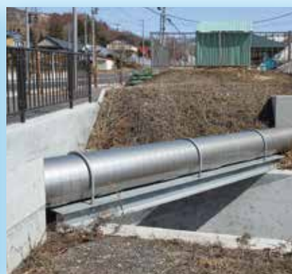
北海道胆振管内 鉾山排水水管橋 400A / φ500 L=6.6m
