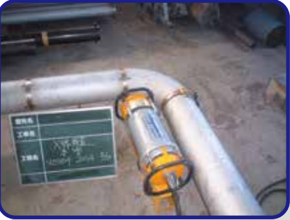
5.X 線検査 溶接完了後、溶接部分にX線検査を 行い溶接管理を行っています。
