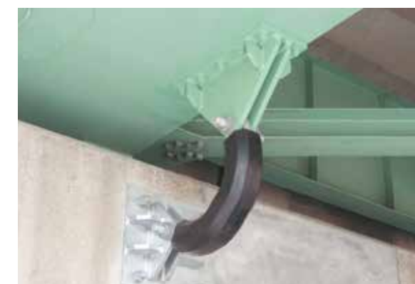
・ゴムチェーン等で橋脚からの落下を防ぎます。 ※ゴムチェーンの製作はしていません。
