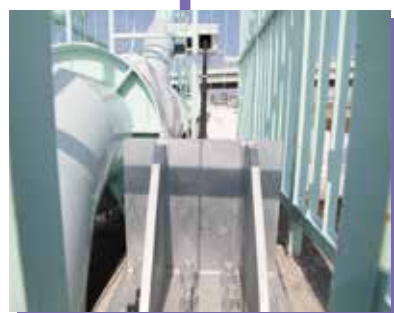
橋軸直角方向へ金具を取付け橋台からの落下を防ぎます。
