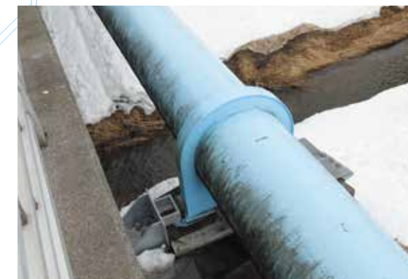
・橋軸直角方向に金具を取付け、橋脚からの落下を防ぎます
