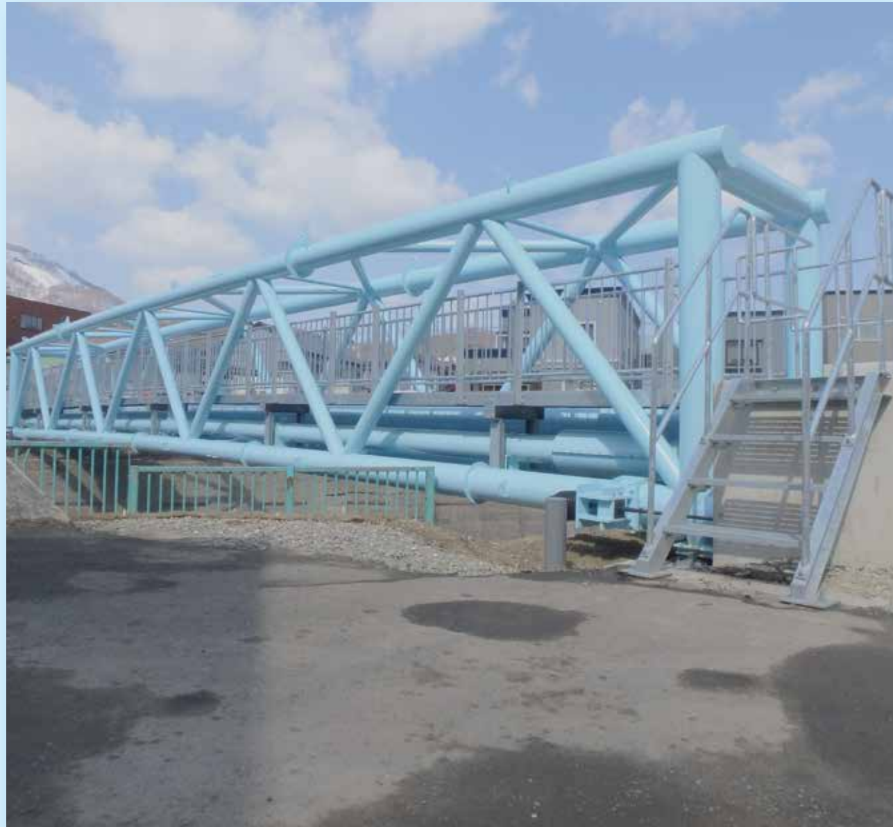
北海道後志管内 勝納水管橋 600A/700A 200A/300A L=35.55m
