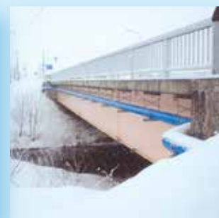
北海道宗谷管内 豊富橋 150A(水道ボリ) / 250A L=51.1m
