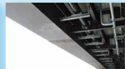
北海道石狩管内 虎杖橋 400A / 500A L=94.0m
