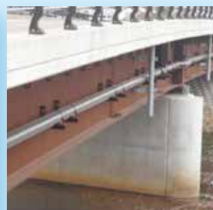
北海道渡島管内 久根別 7 号橋 75A(下水ボリ) / 200A L=70.0m
