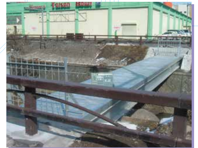
電線共同溝用桁製作・設置
