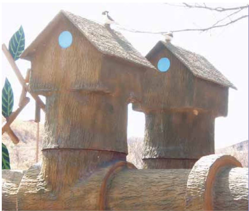
FRP 加工で製作された鳥の巣を空気弁 BOX としています。
