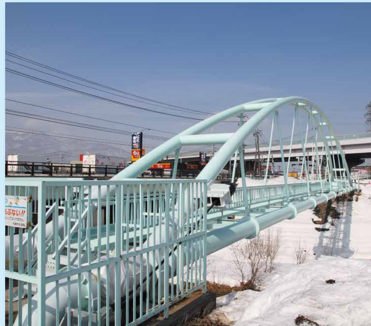
北海道石狩管内 琴似発寒川水管橋 500A 2条 支間長=53.8m
