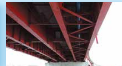
北海道石狩管内 紅葉橋 250A / 350A L=75.09m
