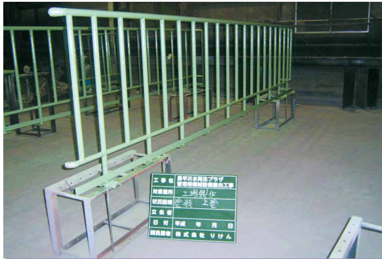
施設内手摺製作・設置
