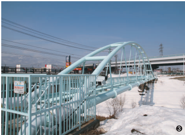
③耐震補強水管橋（北海道）
