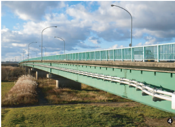
④電線管橋梁添架（青森県）
