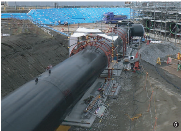
⑥鋼管布設（北海道）
