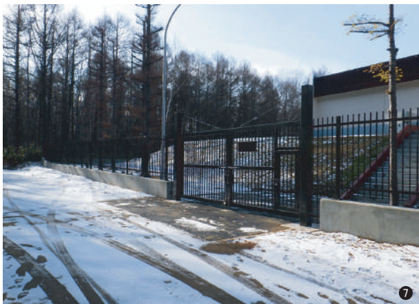
⑦保安強化施設柵（北海道）
