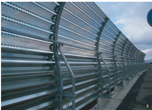
⑧高性能吹止柵（山形県）
