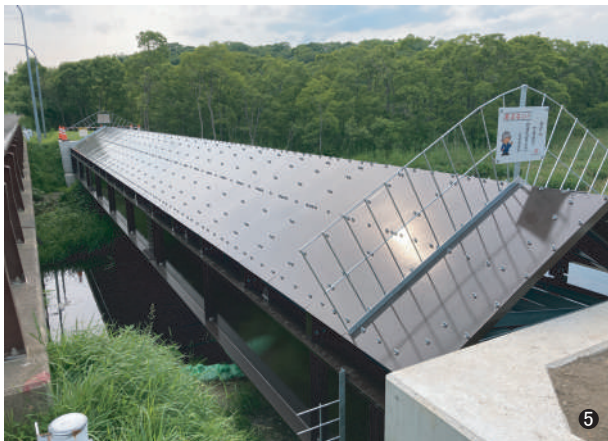
⑤共同電線溝橋（北海道）
